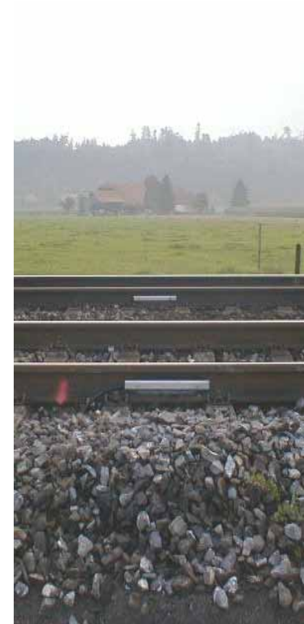
Dehnmessstreifen als Achszähler
