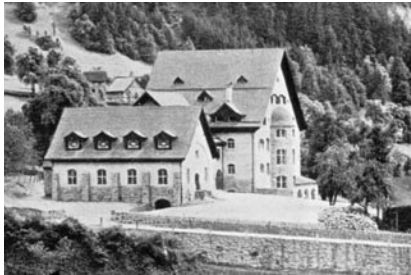
Toiture en pente
