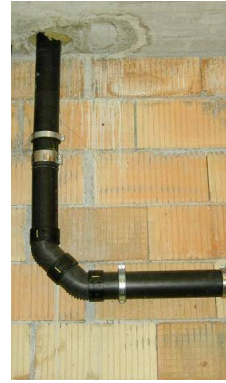
Fallstrang mit Umlenkung
