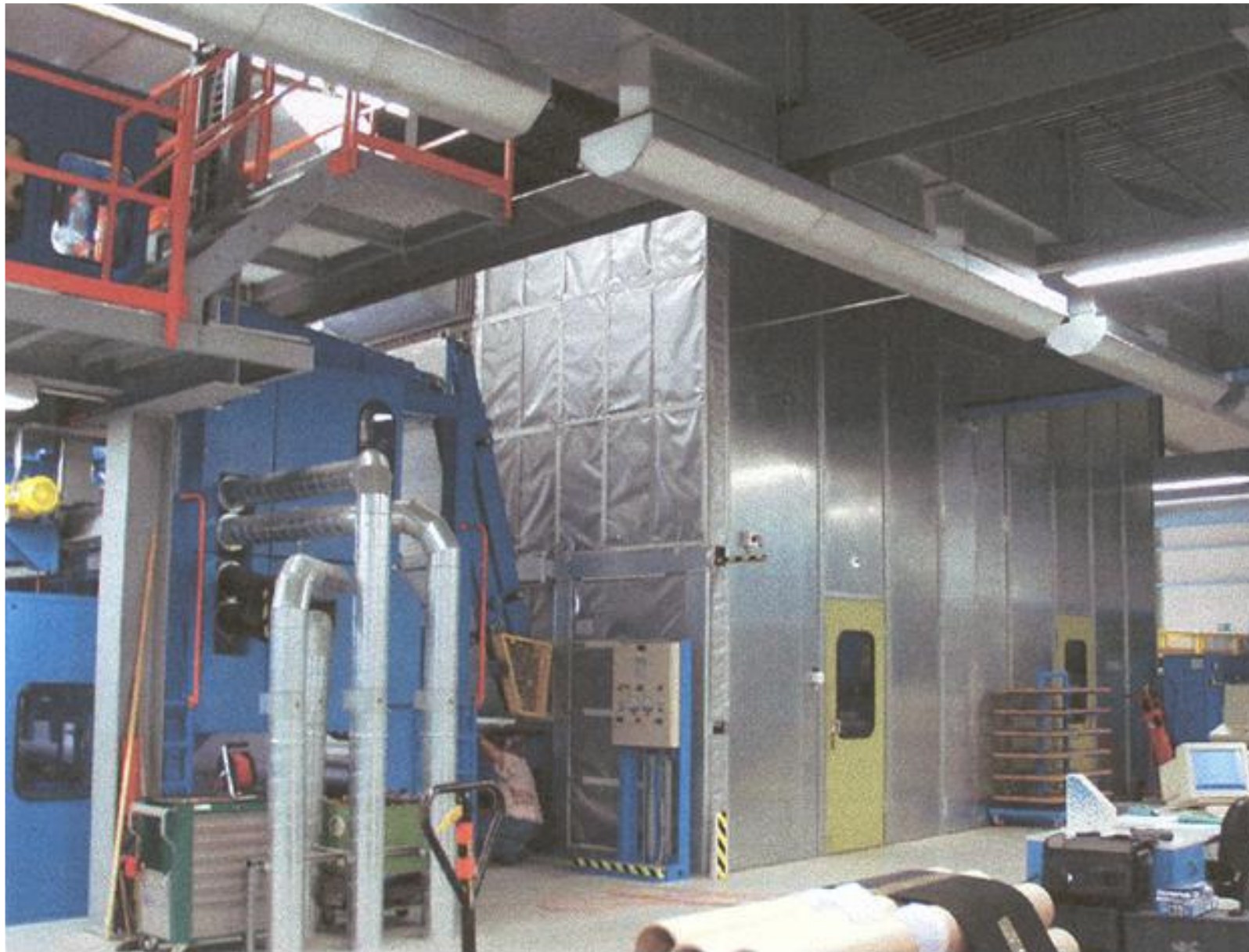
Nadelfilzmaschine nach der Montage eines ETIS- Lärmabsorber-Systems
